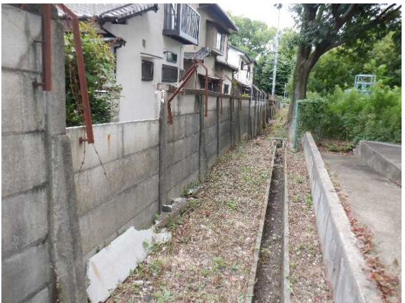
（藤森）囲障改修
