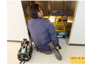
エレベーター点検立会い
