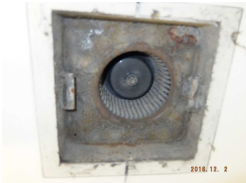
課外活動施設文系男女トイレ換気扇のカバー外し清掃
