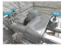
国際交流会館 左 電磁弁バイパス 保温剤がし
