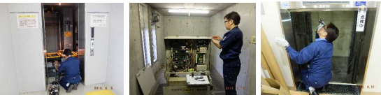
昇降機点検実施状況 機械室点検実施状況 小荷物昇降機点検実施状況
