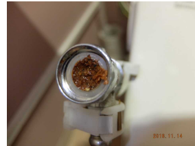
トレーニングセンター多目的トイレ給水タンクの水量が少ない修理
