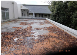
教育実践センター機構棟北屋上ルーフドレンの落葉の除去清掃
