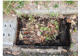
本館庁舎東キュービクル道路前の排水溝の汚泥・木の根等の除去清掃
