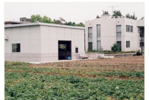
リサイクルシステム実験実習棟 (手前の建物)
